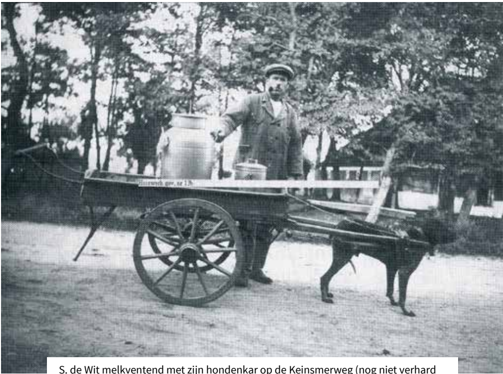
S. de Wit melkventend met zijn hondenkar op de Keinsmerweg (nog niet verhard –dus waarschijnlijk in de jaren '20); op de achtergrond boerderij 'Jagerslust' (nu zorgcentrum 'De Zandstee'). Privé-collectie.
